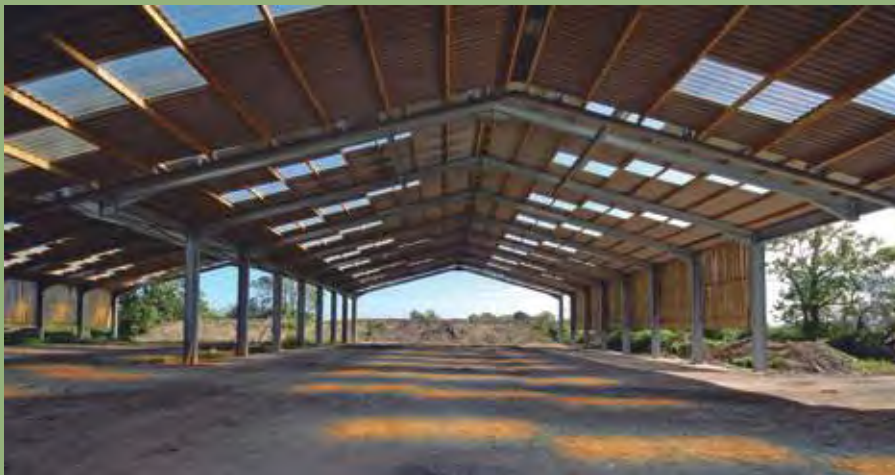
CUBIERTAS DESDE ABAJO
